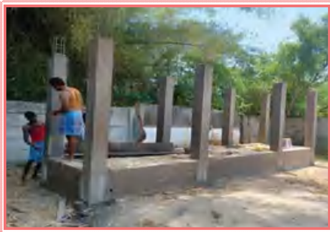
तमिलनाडु के कुड्डालोर जिले के एक सरकारी उच्चतर माध्यमिक विद्यालय में टॉयलेट (शौचालय) का निर्माण Construction of Restrooms (Toilets) in a Government Higher Secondary Schools of Cuddalore District, Tamil Nadu
